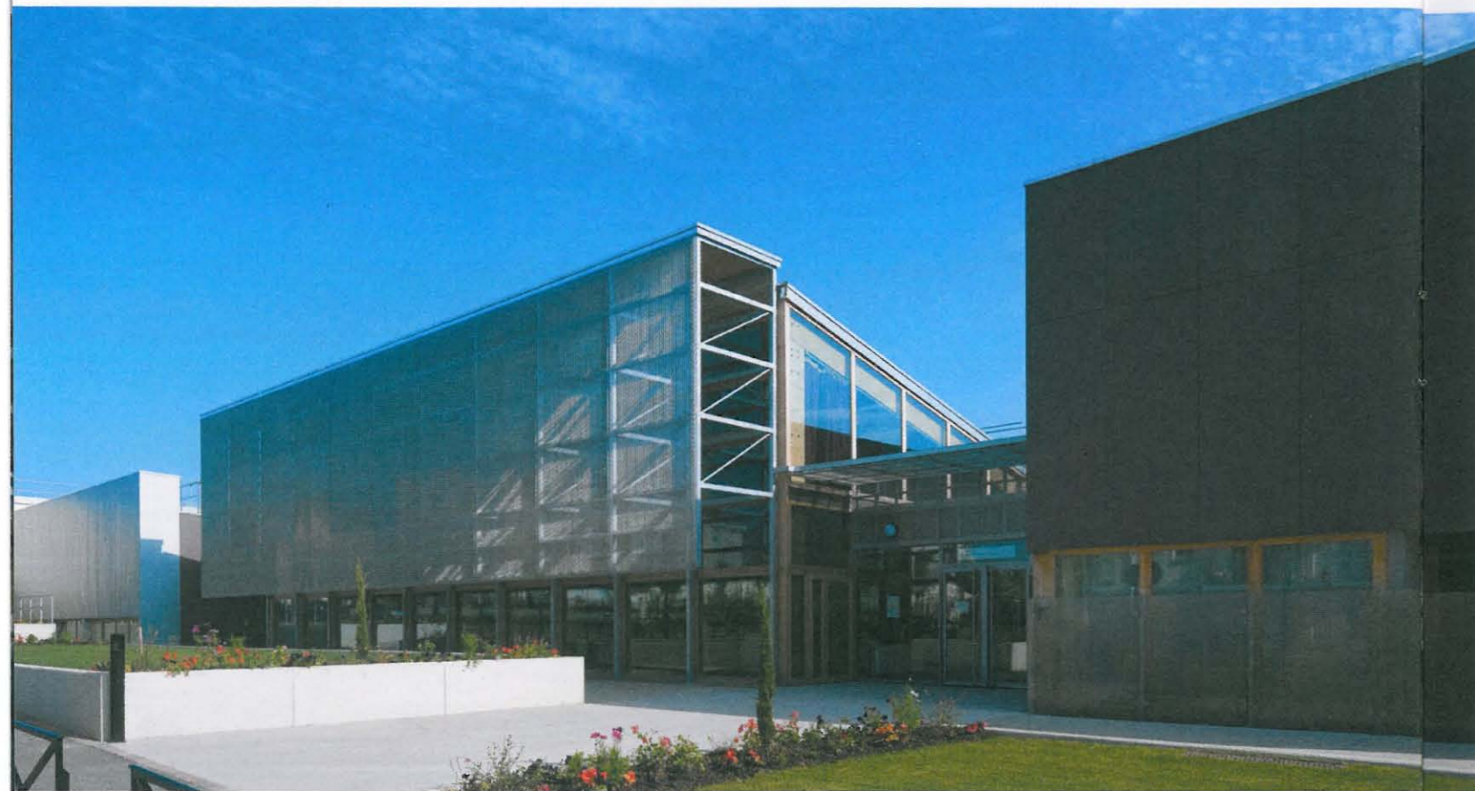
Des panneaux coulissants électriques protègent la coursive de l'école élémentaire. En position ouverte, ils disparaissent dans le mur à double-fond de 15 cm de bow-window.
