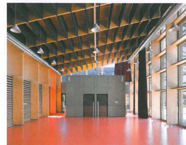
Pour traiter l'acoustique, plusieurs solutions ont été retenues : baffles acoustiques, tympan en médium, panneaux en lattes de mélèze avec voile acoustique et laine minérale.
