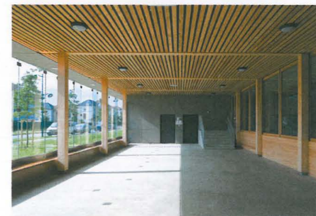
Le préau est partiellement fermé par une paroi en pli de verre composée de vitrages Securit autoportants de 90 cm de large, maintenus entre eux par pattes métalliques.
