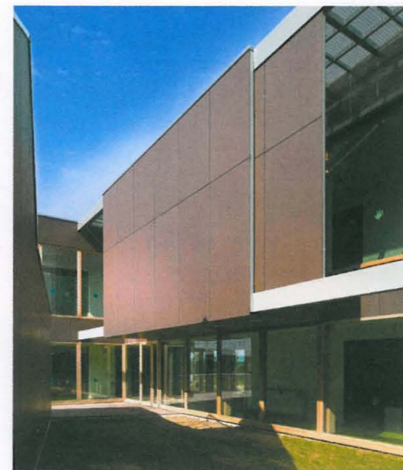
Des panneaux coulissants électriques protègent la coursive de l'école élémentaire. En position ouverte, ils disparaissent dans le mur à double-fond de 15 cm de bow-window.
