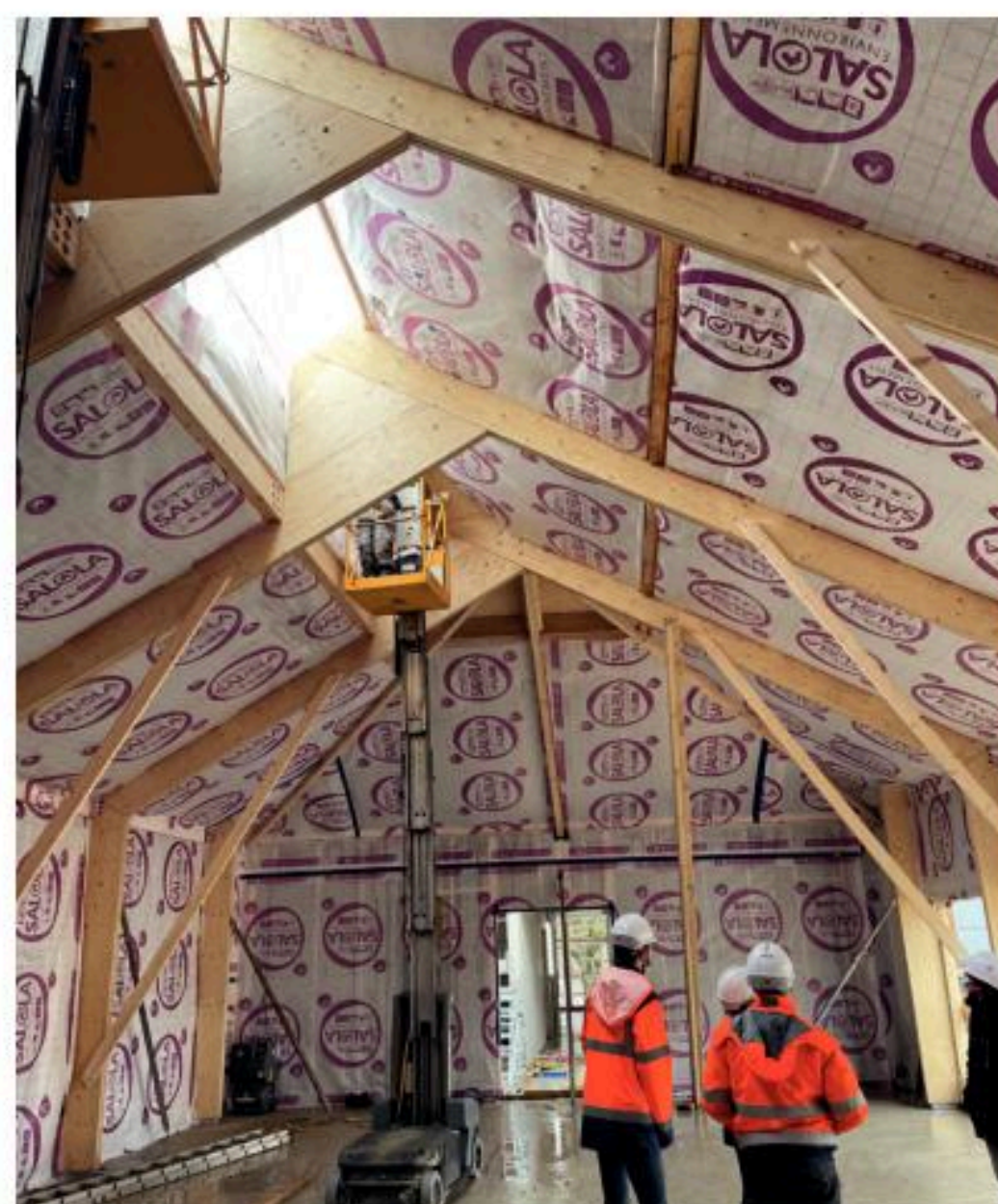
↑ Pose des châssis en toiture.
