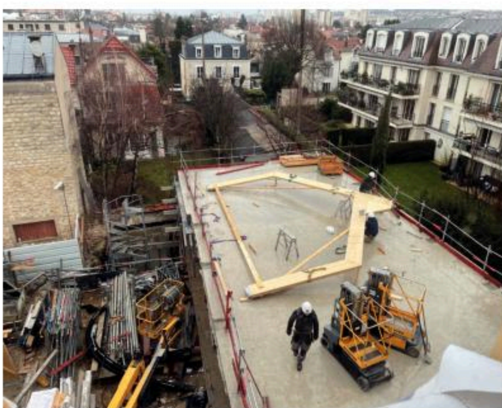
↑ Mise en place des fermes.
