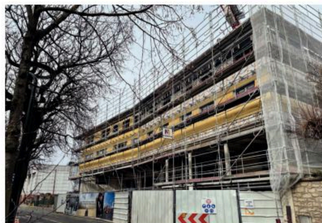
↑ Réalisation du bardage.
