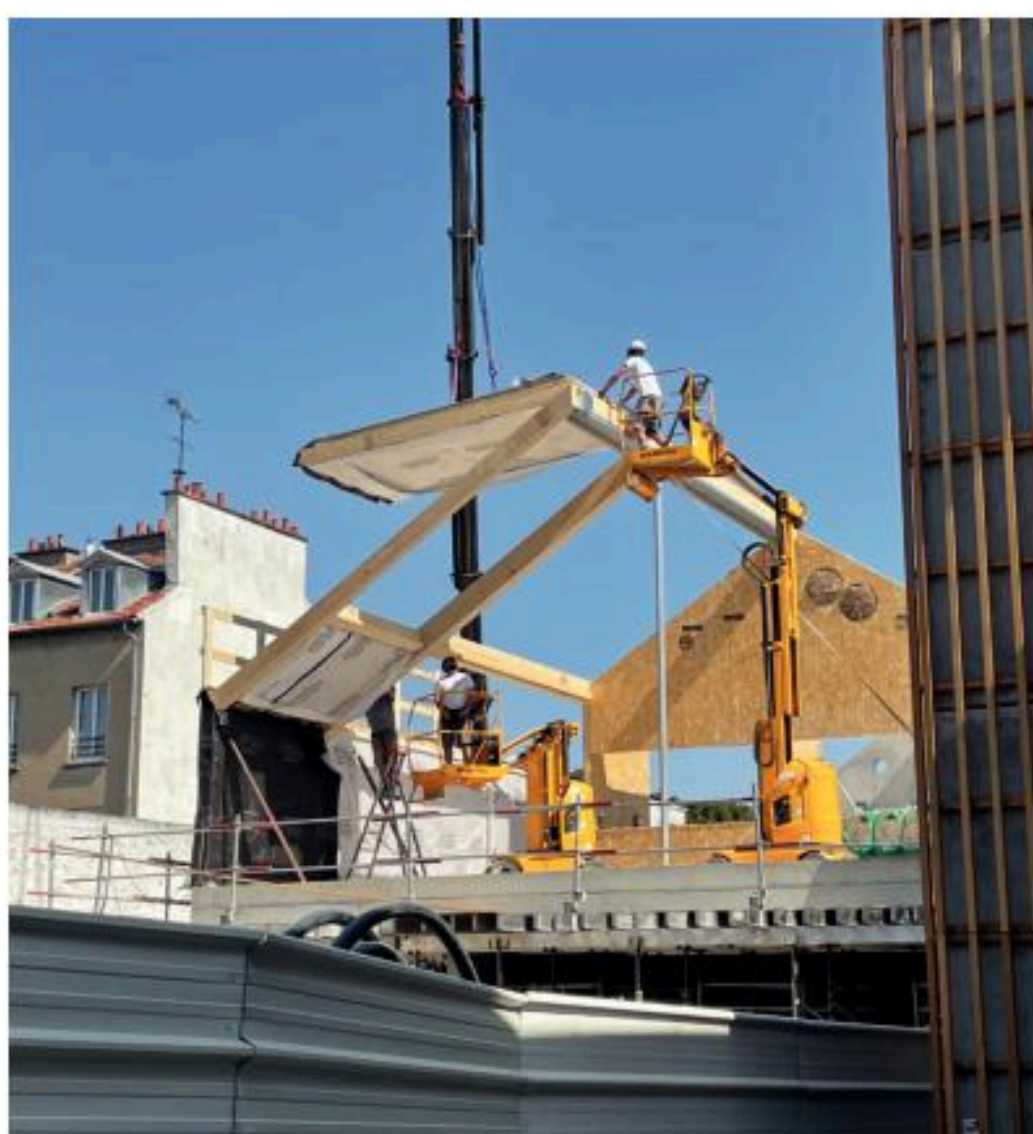
↑ Pose des caissons de toiture.
